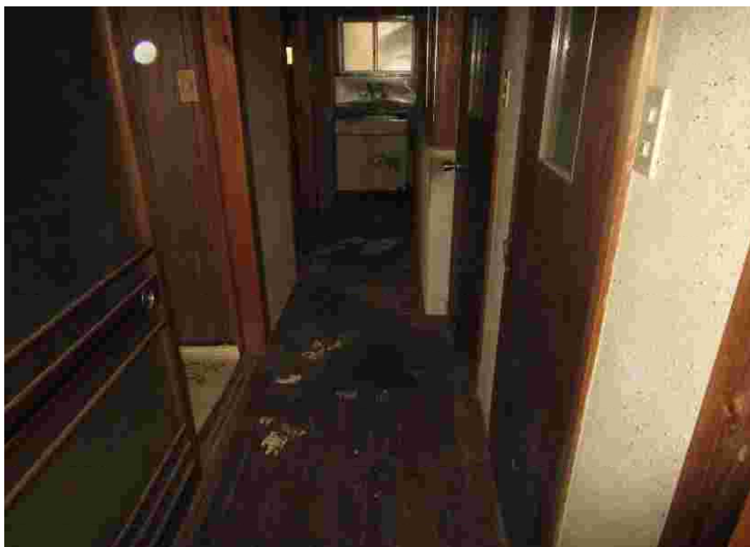
撮影方向⑨（廊下）
